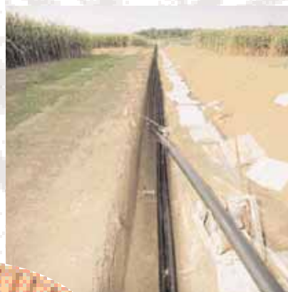
Pokládání kabelů 110 kV. Tyto kabely jsou součástí sítě vysokého napětí, která přivádí proud do regionů a městských aglomerací. Na obrázku vlevo vidíme montáž rozvodny velmi vysokého napětí (380 kV).
