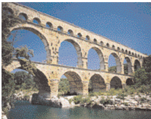
Akvadukt Pont-du-Gard ve Francii byl mistrovským dílem architektury. Sloužil jako vodovod i most.
